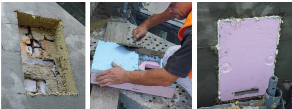
Fot. 104. Szczelina pomiędzy ceglami w ścianie tej kamienicy prowadziła do wykorzystywanego co roku zimowiska nietoperzy (DZ)
