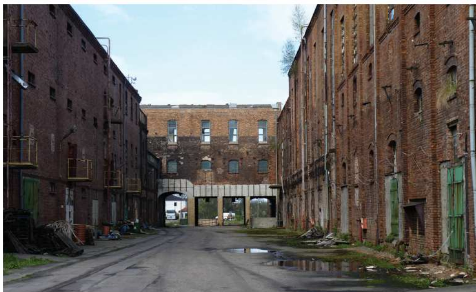
Fot. 20. Stare, zrujnowane budynki zakładów przemysłowych są pełne siedlisk dogodnych dla ptaków i nietoperzy (DZ)
