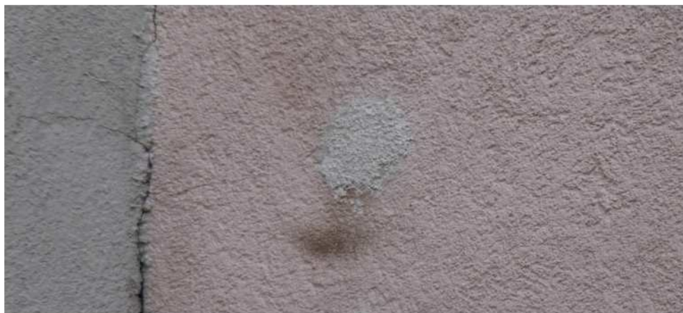
Fot. 134. Pod tą zamurowaną szczeliną widać wyraźne ślady użytkowania przez ptaki. Nawet jeżeli zamknięto ją, kiedy ptaków nie było w środku, nadal jest to niszczenie siedliska, na które należy uzyskać zgodę RDOŚ (DZ)
