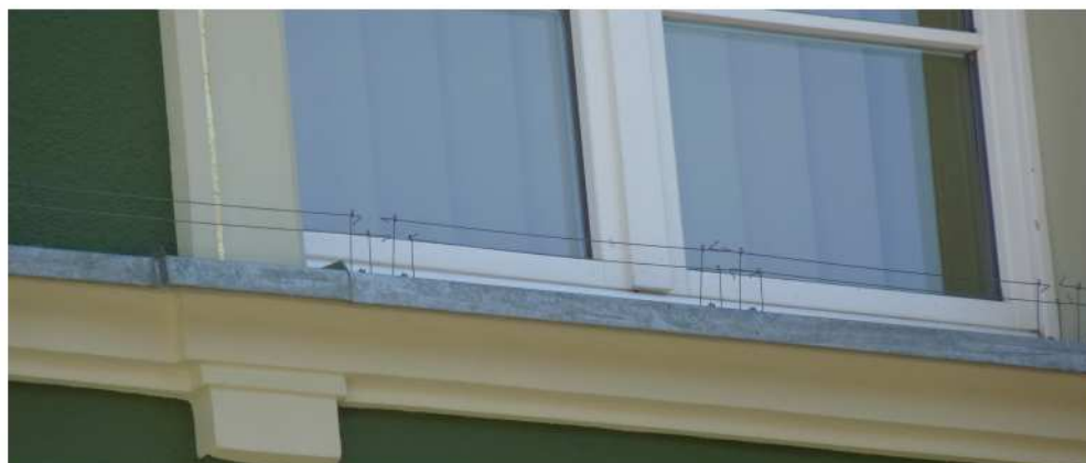
Fot. 129. Elewację Urzędu Miejskiego w Szczecinie zabezpieczono przed gołębiami miejskimi za pomocą niemal niewidocznych, ale skutecznych prętów obrotowych (DZ)
