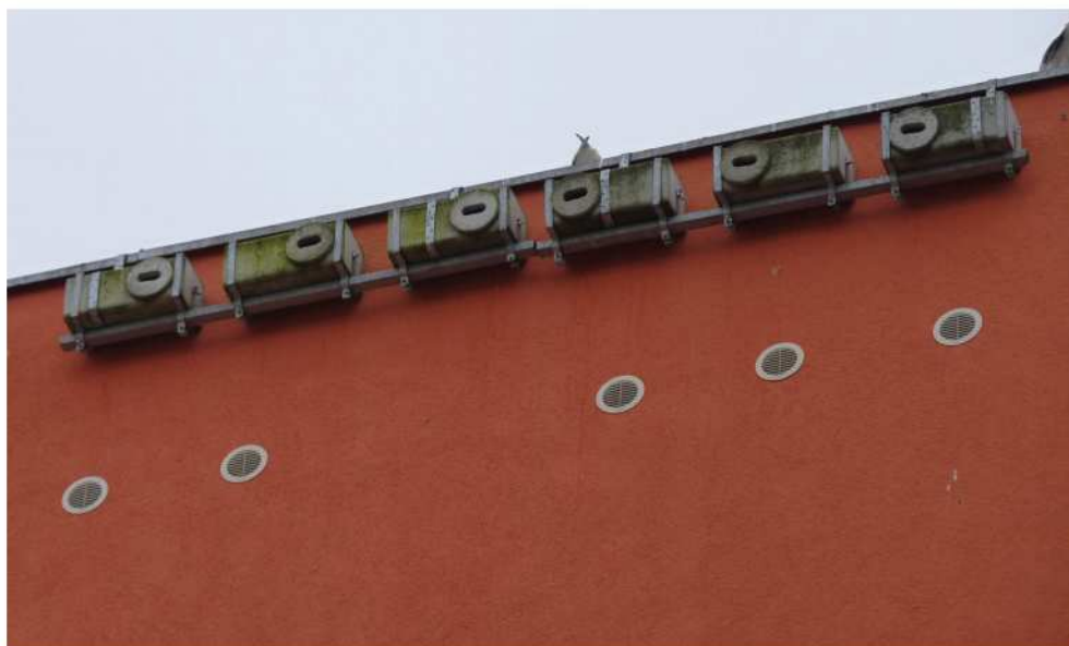
Fot. 108. Skrzynki dla jerzyków wykonane z trocinobetonu i zawieszane na stelażu (DZ)
