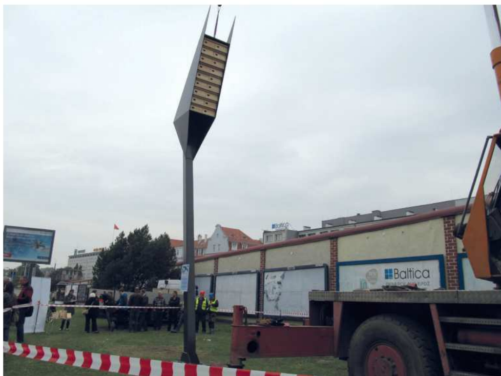
Fot. 117. Montaż wieży jerzykowej w Gdańsku (JT)
