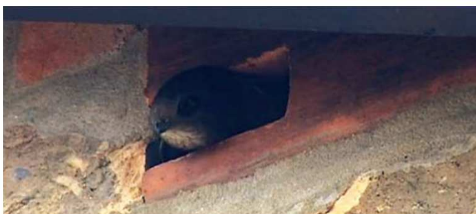
Fot. 113. Skrzynka ceramiczna wbudowywana w konstrukcję budynku zamiast zwykłych cegieł stanowi siedlisko chętnie zajmowane przez jerzyki i inne ptaki (DN)
