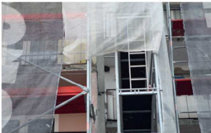
Fot. 1. Gniazdo oknówki uwieszone między rusztowaniami. Budynek ul. Pultusk.
