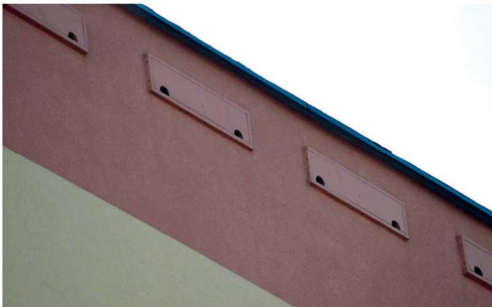
Fot. 106. Montowanie skrzynek podtynkowo, na wysokości stropodachu niweluje potencjalne oddziaływanie mostków termicznych na właściwości cieplne budynku (AT)
