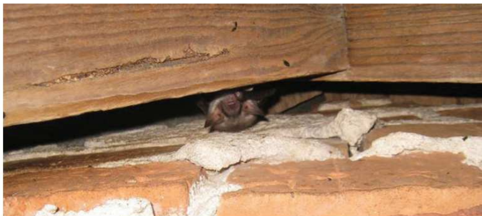
Fot. 92. Nocek duży kryjący się pomiędzy krokwią a ceglana ścianą (KK)
