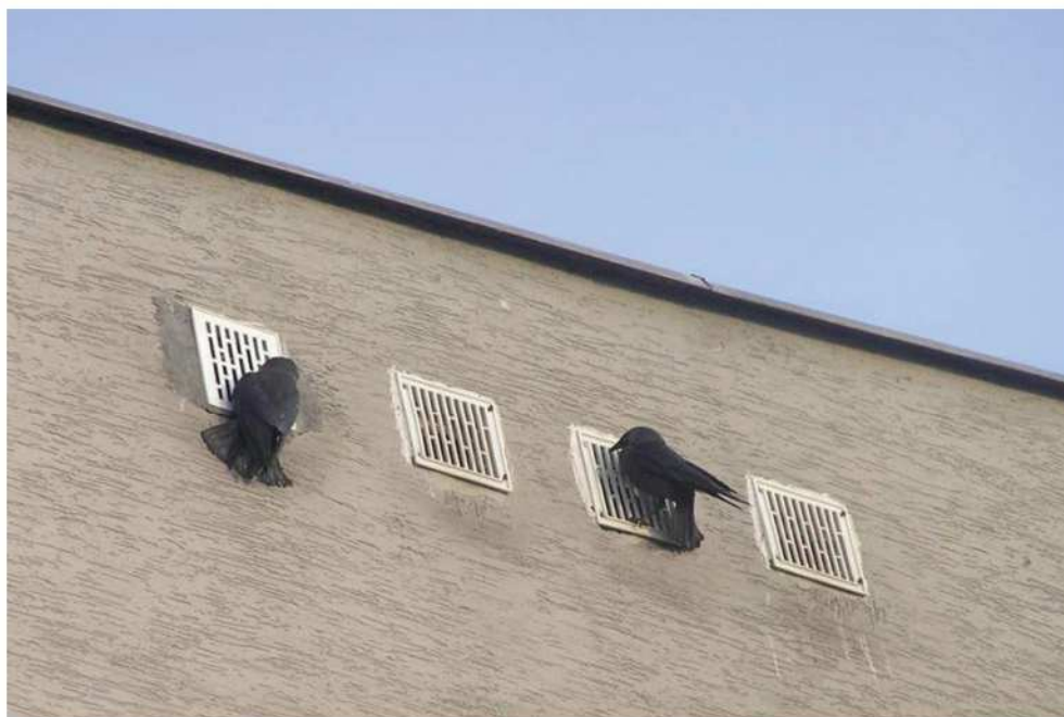
Fot. 11. Kawki próbujące się dostać do miejsc gniazdowania w stropodachu, który zakratowano. Pracując wytrwale potrafią wyrwać kratki po jakimś czasie (ML)
