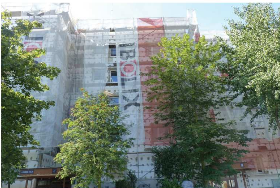
Fot. 21. Budynek wielkopłytkowy w trakcie docieplenia (DZ)
