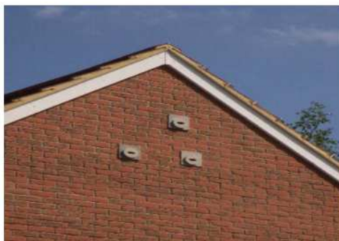
Fot. 114. Niemal niewidoczna skrzynka wewnętrzna chroniona przed warunkami atmosferycznymi może być wykonana z cienkiej i taniej sklejkki. Do jej wnętrza prowadzi chropowata, ułatwiająca zwierzętom dostawanie się do wewnątrz rura PCV poprowadzona przez warstwę termoizolacyjną oraz ścianę (DN)
