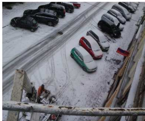
Fot. 26. Zastosowanie podnośnika hydraulicznego pozwala na wykonanie niezwykle szczegółowej inwentaryzacji budynku (DZ)
