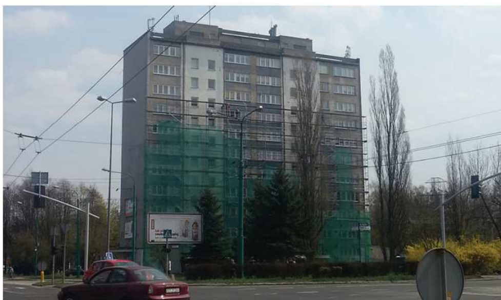
Fot. 135. Remontowany blok (DC)
