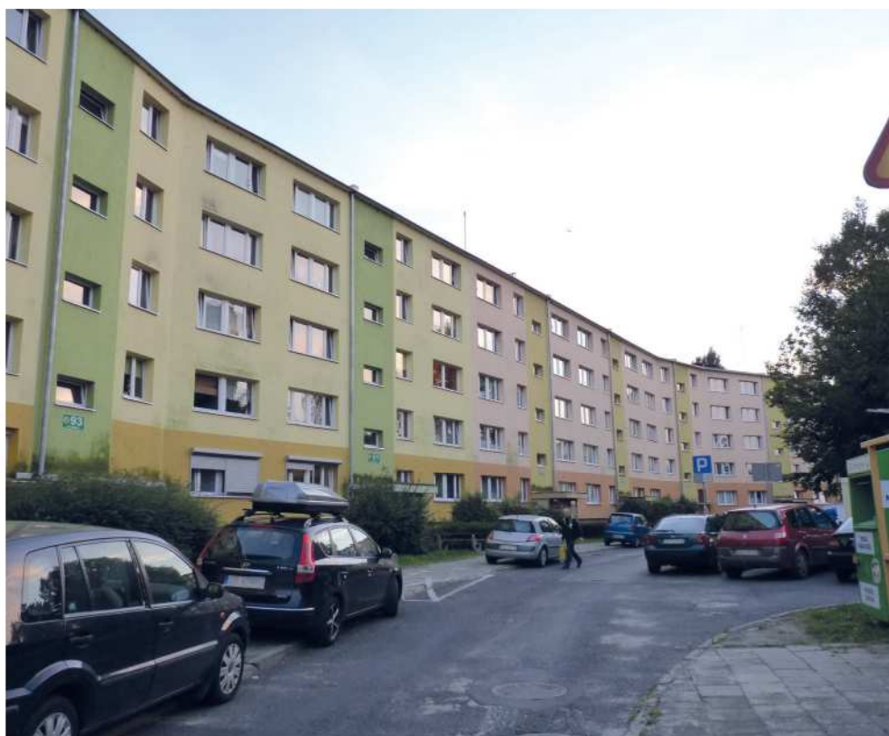
Fot. 1. W stropodachu tego bloku gniazdują setki par jerzyków (DZ)
