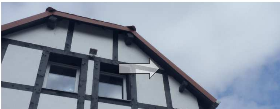
Fot. 80. W tym domu wewnątrz dachu znajdowała się kolonia rozrodcza karlika drobnego licząca prawie 700 osobników (DZ)
