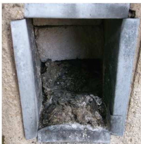
Fot. 69. Gniazdo gołębi miejskich w otworze wentylacyjnym w ścianie kamienicy. Składa się głównie z patyków i kału (DZ)
